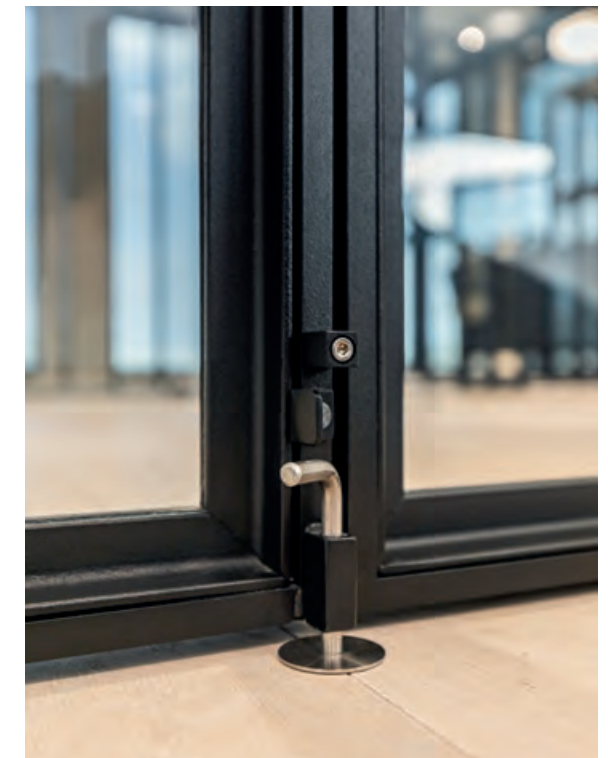
Feststeller eines Türflügels latch of a door wing
